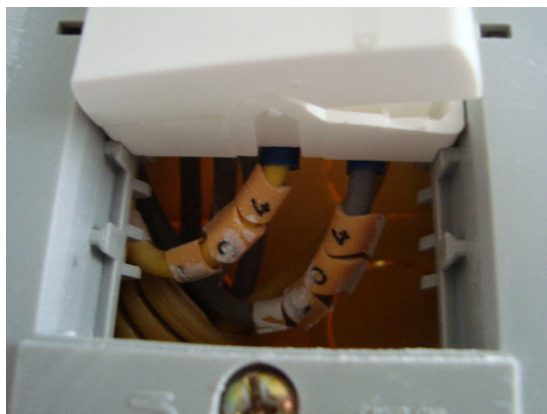
Figura 5 - Identificação de condutores, tomadas e interruptores
