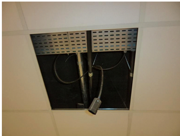
Figura 9 – Derivação para luminárias (prensa-cabo e plug)
