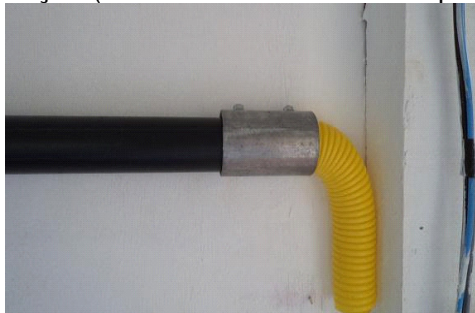
Figura 1 – Transição de eletroduto rígido para corrugado
