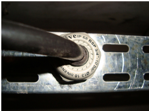
Figura 9 – Derivação para luminárias (prensa-cabo e plug)
