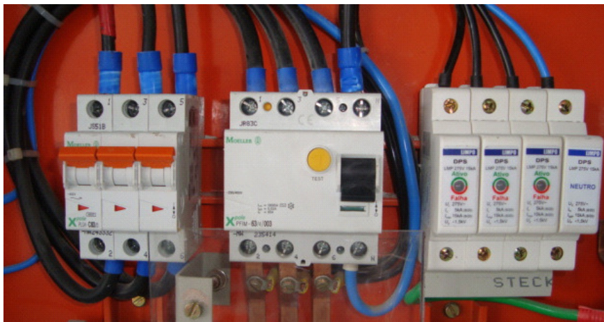
Figura 4 – Disjuntor, dispositivo DR e DPS em quadro
