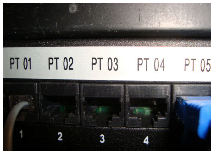
Figura 15 – Patch panel com identificação de pontos
