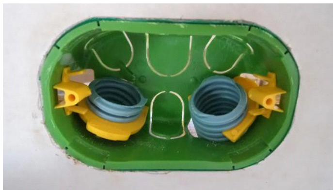
Figura 2 – Caixa de ligação em drywall
