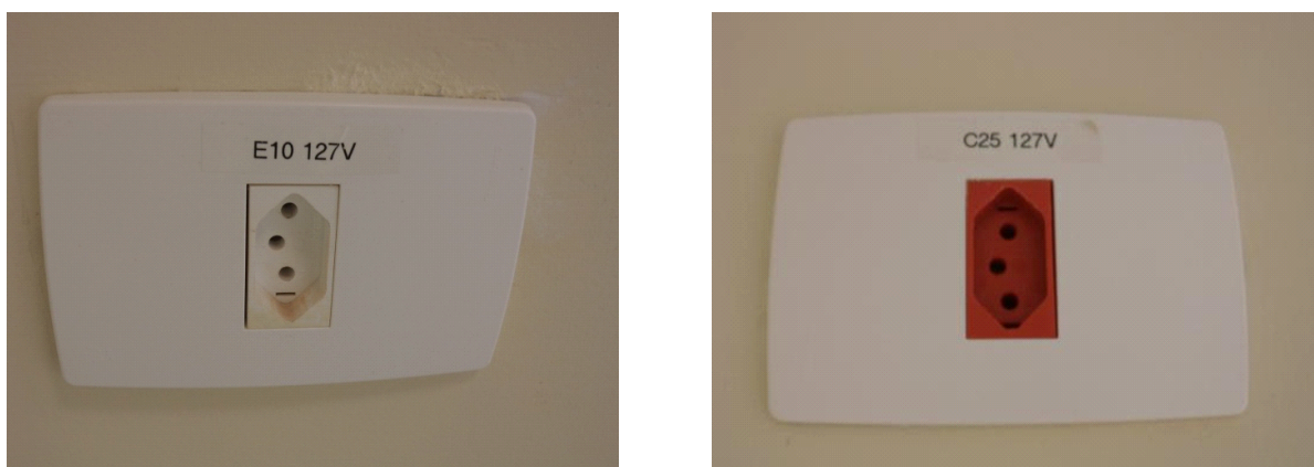
Figura 8 – Tomadas comum e estabilizada
