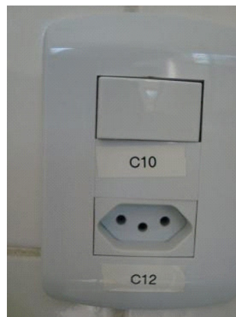
Figura 5 - Identificação de condutores, tomadas e interruptores
